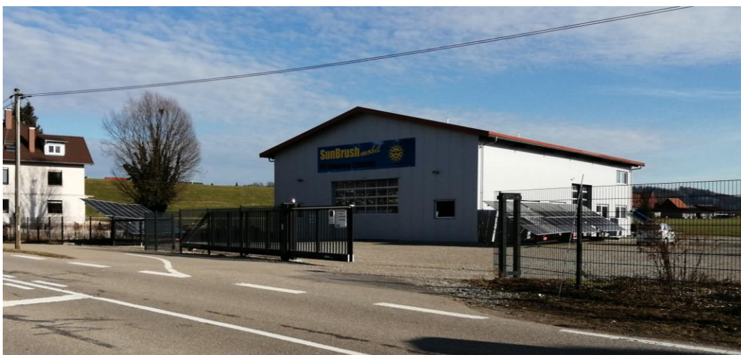
Abb. 3 Bestehende Gewerbehalle von der Straße „Am Bahnhof“
